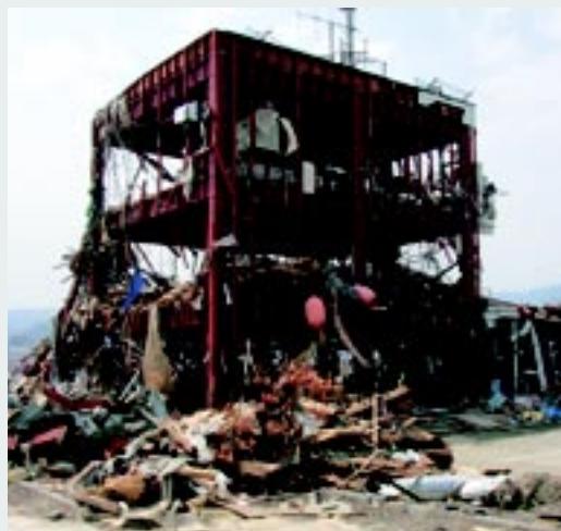
▲南三陸町の防災対策庁舎
