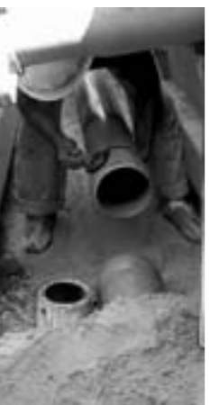
▲下水管の布設
