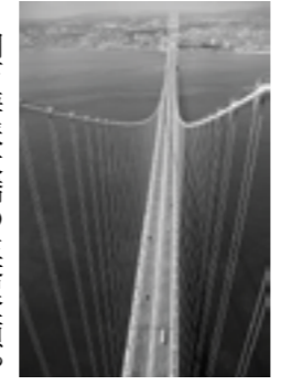
▲明石海峡大橋の主塔
