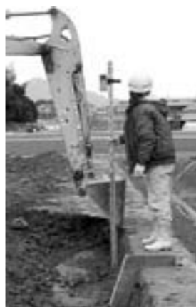
▲コンクリート畦畔の整備
