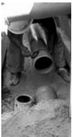
▲下水管の布設
