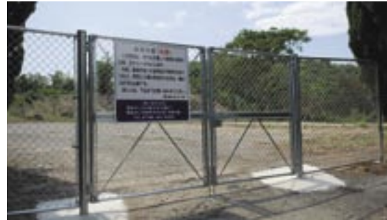
▲危険な場所があることから、門を設置
