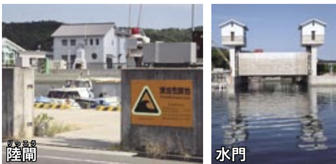
▲福良港内の37基の水門や陸閘、樋門は手動での操作もできるほか、津波警報が出た際、自動閉鎖できるよう整備が進められます
