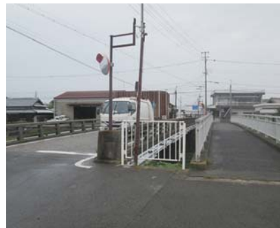
▲県道 66 号線 掃守橋の現状
