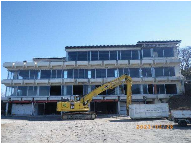
道の駅うずしお解体前
