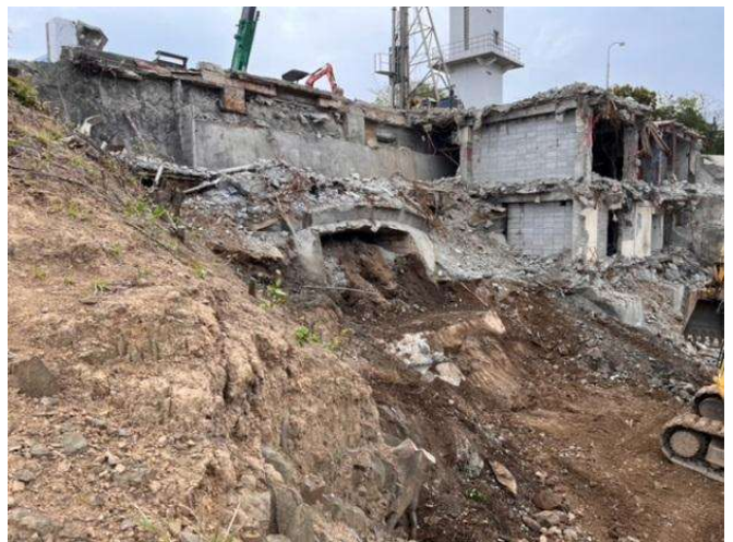
4/11 解体中に北側射撃口が出現
