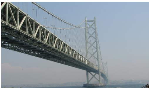
(明石海峡大橋)
