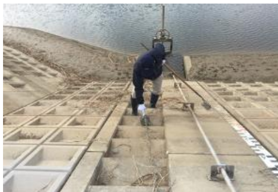
池の点検の様子
