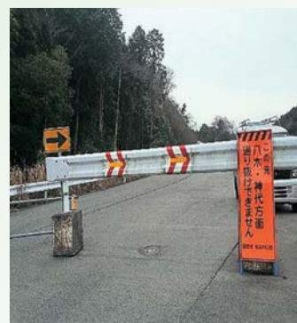
▲来年度に工事着手するオニオン道路（未開通の八木工区）
