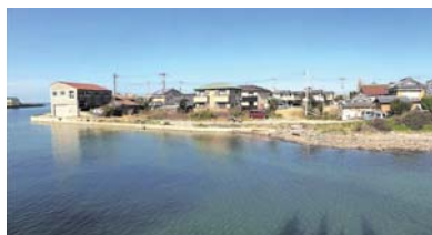
▲掘岸川護岸(松帆)
