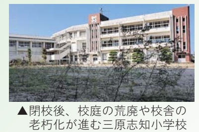
▲閉校後、校庭の荒廃や校舎の老朽化が進む三原志知小学校
