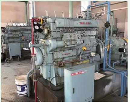
▲故障したポンプ、交換部品がない50年もの
