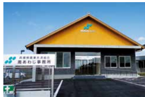
新たに建設された県農業共済組合南あわじ事務所
