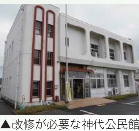
▲改修が必要な神代公民館
