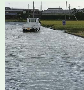
▲大雨により冠水した道路
