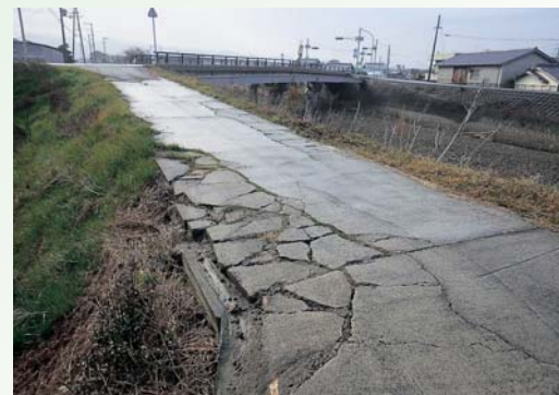
▲破損している道路（榎村松田）※現在は修復が終わっている
