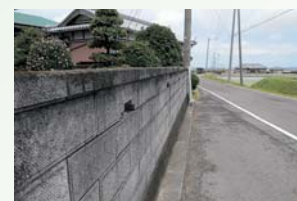
▲通学路ブロック塀の安全点検実施
