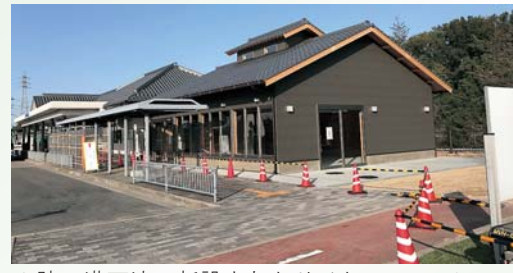
陸の港西淡に新設されたサイクルステーション
