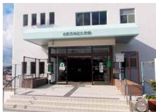
▲改修工事が完了した北阿万地区公民館の外観
