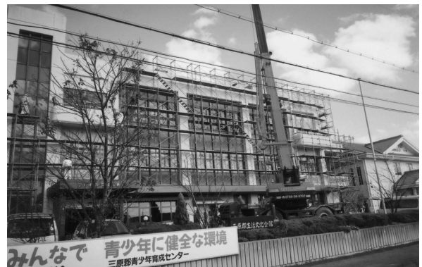
中央庁舎改修工事 (三原郡生活文化会館)
