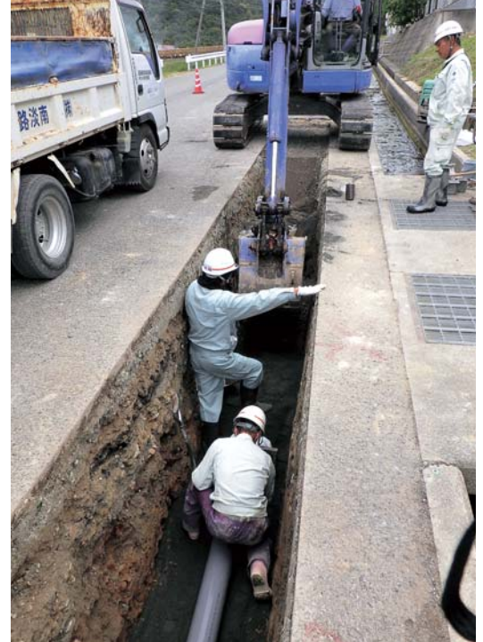
▲新たに下水道管を道路下に敷設する工事 (八木大久保)
