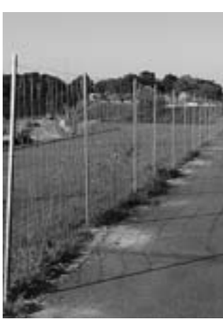
▲設置した野生動物防護柵
