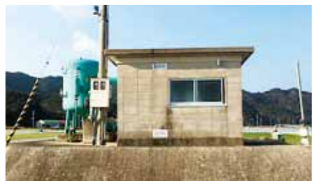
▲整備事業を計画している農業用排水施設
