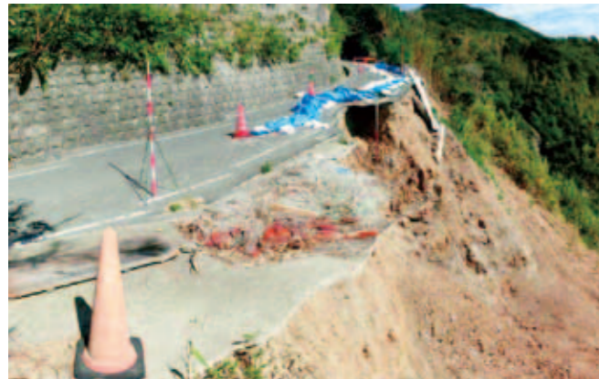
▲崩落が生じた灘仁頃の市道
