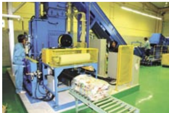
▲その他プラスチックの圧縮梱包（センター内）
