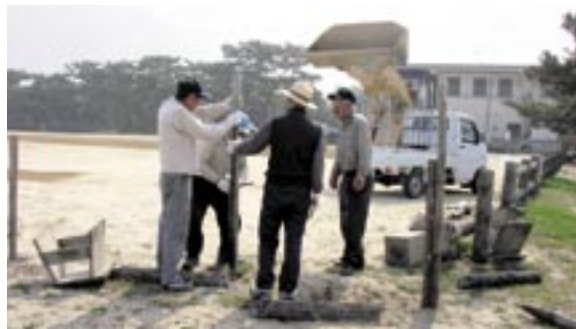
▲杭打ちしてネット張り。重機などを持ち込んで整備
