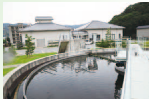
▲下水道処理施設
