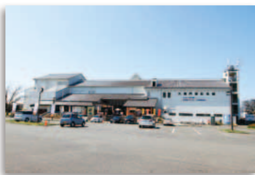
▲大規模改修工事を行う大鳴門橋記念館
