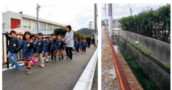
▲完成した歩道を歩く賀集保育所の園児(左)、工事前の水路
