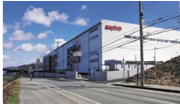
▲企業団地に完成した三洋エナジー南淡(株)三原工場
