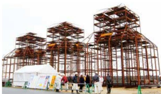
▲淡路瓦約2千枚を使った高さ15メートルの高層型増殖礁
