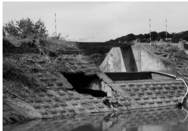
▲8月10日前後にかけて市内各地に豪雨をもたらした台風11号によるため池堤体の被害状況（賀集）
