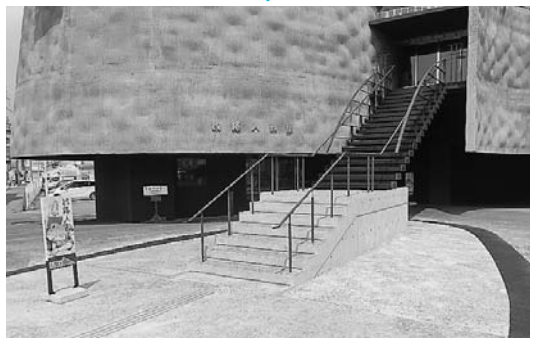
▲スロープから階段に付け替えられた淡路人形会館の入り口
