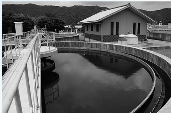
▲賀集浄化センター
