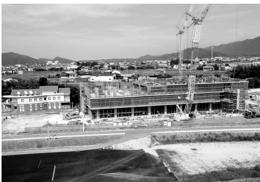
▲来年4月の開庁を目指して建設が進む新庁舎（7月中旬撮影）
