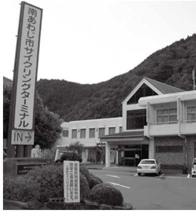
▲サイクリングターミナルの改修
