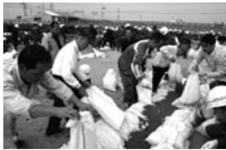
▲住民も参加した土のう積み
