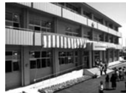
▲松帆小学校改築及び大規模改修工事(16年度～18年度)
