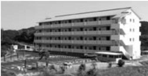
▲完成したしづおり第2団地 住宅構造=鉄筋コンクリート造4階建。戸数=公営住宅16戸、特定公共賃貸住宅8戸。設備=集会所(別棟)、有料駐車場、オール電化、エレベータ、小公園。総事業費=4億2,555万円(13年度~18年度)
